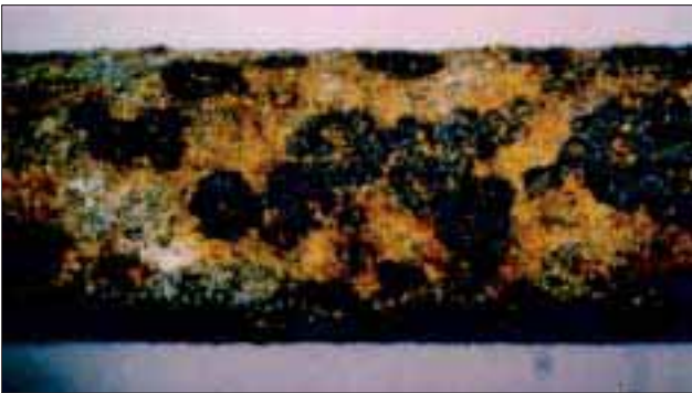
Abb. 1: Bewehrungskorrosion infolge Chloridangriffs (Expositionsklasse XS3)
