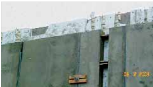
Abb. 5: Unsachgemäßes Ausschäumen
