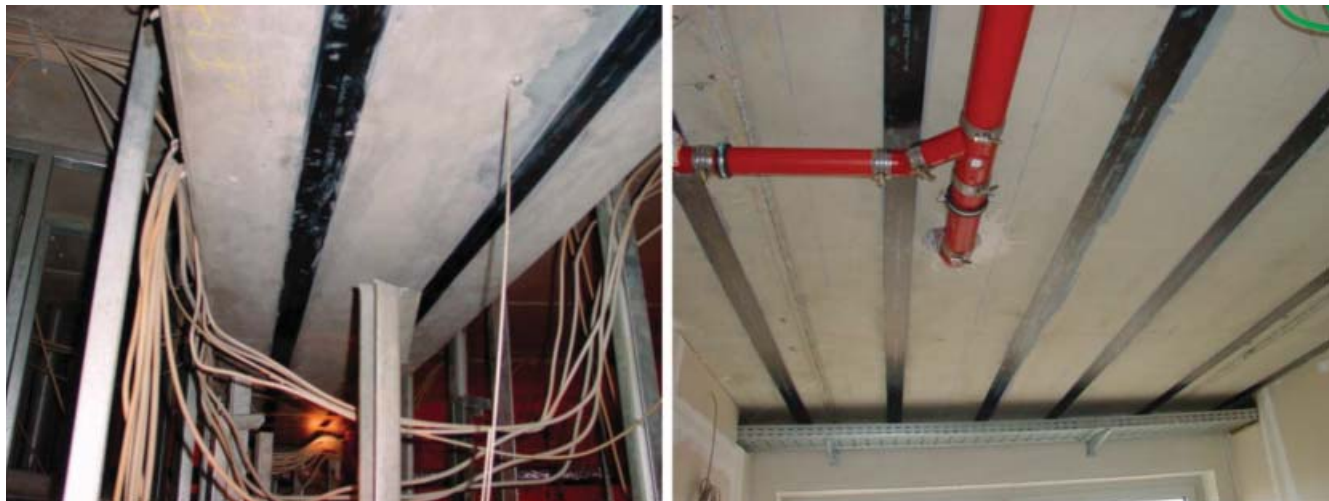
Abb. 11: Eingebaute Verstärkung mit CFK-Lamellen als äußere Bewehrung – links: Unterzug; rechts: Deckenplatte
