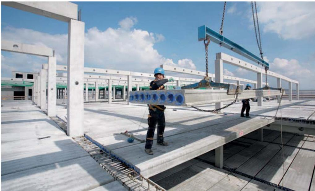
Abb. 11: Montage von Spannbetonhohlplatten
