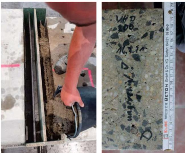
Abb. 9: Hohlraum-Verfüllung zu Erhöhung der Querkrafttragfähigkeit
