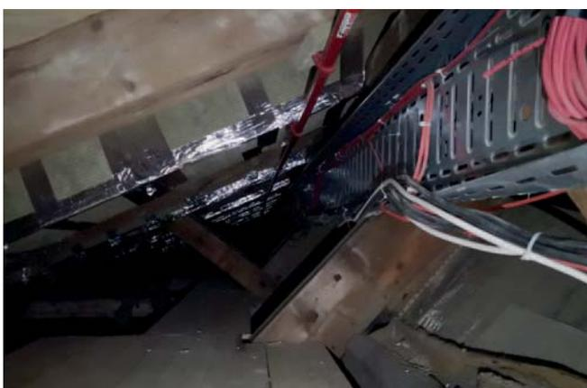
Abb. 9: Mit Mineralfaserplatten verstärkte Dachsparren
