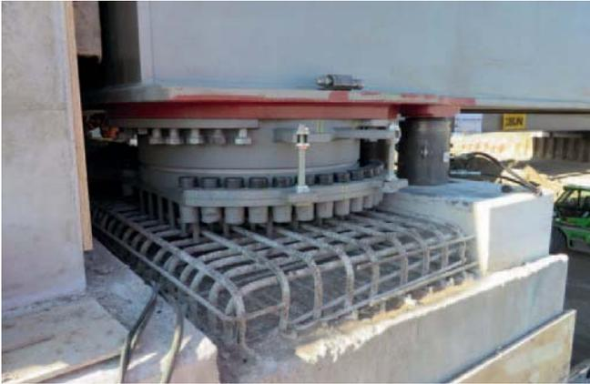
Abb. 13: Die Herstellung der kompletten Lagersockel erfolgte in einem Unterguss, nachdem die Brückenbauwerke mit bereits montierten Lagern in Endlage gebracht worden waren.
