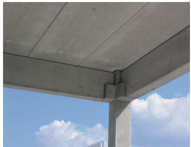
Abb. 2: Typische Anwendungsfälle für Spannbetonhohlplatten
