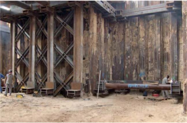
Abb. 7: Hilfsbrückengründung mit Diagonalverbänden und Auflagerung der zweiten Aussteifungsebene
