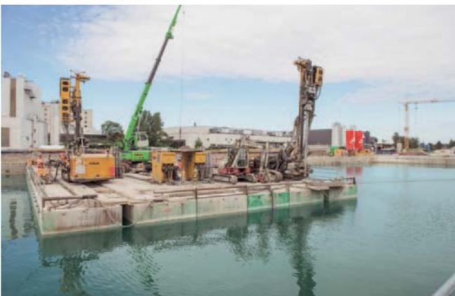
Abb. 15: Die Herstellung der Gewi-Pfähle erfolgte vom Schwimmponton aus. So konnten Schäden an den Gewi-Köpfen bei den Aushubarbeit vermieden werden.
