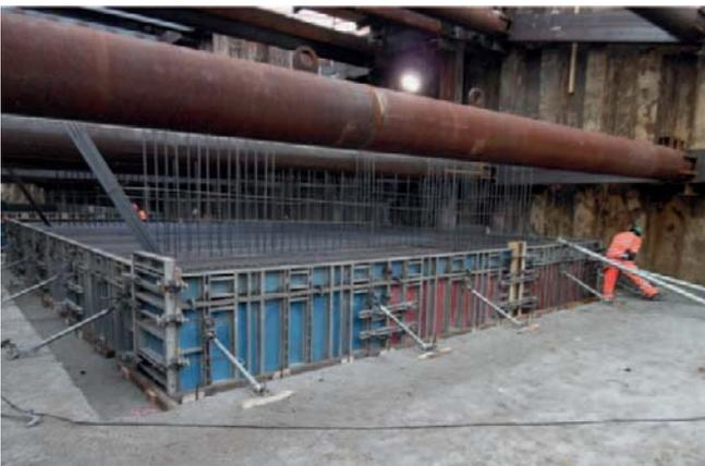
Abb. 8: Eingeschalte Bodenplatte des westlichen Widerlagers mit Baugrubenaussteifung
