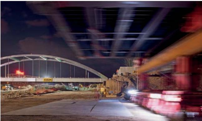
Abb. 14: Einfahrt des Bauwerkes 1.30, das Bauwerk 1.31 befindet sich bereits in Endlage auf Hydraulikpressen
