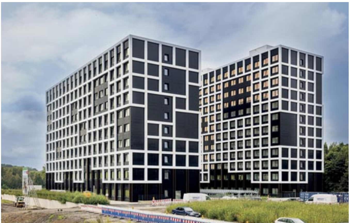
Abb. 4: Community Campus Bochum, Europas höchstes Modulgebäude. Die Apartment-Module werden, einschließlich Küche und Bad, als fertige Module angeliefert.
