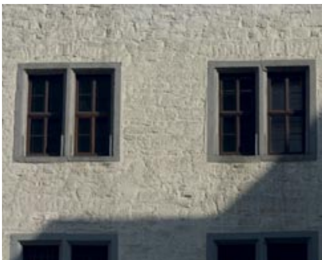
Abb. 5: Die Anletermöglichkeit war wegen der abweichenden Situation in der Örtlichkeit zu überprüfen. Diese Wand war ein besonders kniffliger Einzelfall: Hier wurde mit der Brandschutzdienststelle abgestimmt, dass man bei entsprechender Gefahrsituation die wertvollen steinernen Gewände notfalls zerstören darf, um gegebenenfalls anleiten zu können.
