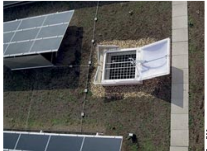
Abb. 2: ... sehr nahe bei den Natürlichen Rauch- und Wärmeabzugsgeräten aufgestellt.
