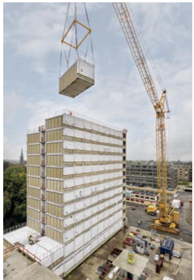
Abb. 2: Einheben von Raummodulen auf der Baustelle des Community Campus Bochum, eines Gebäudekomplexes mit 737 Wohneinheiten und einer Grundfläche von 4150 Quadratmetern
