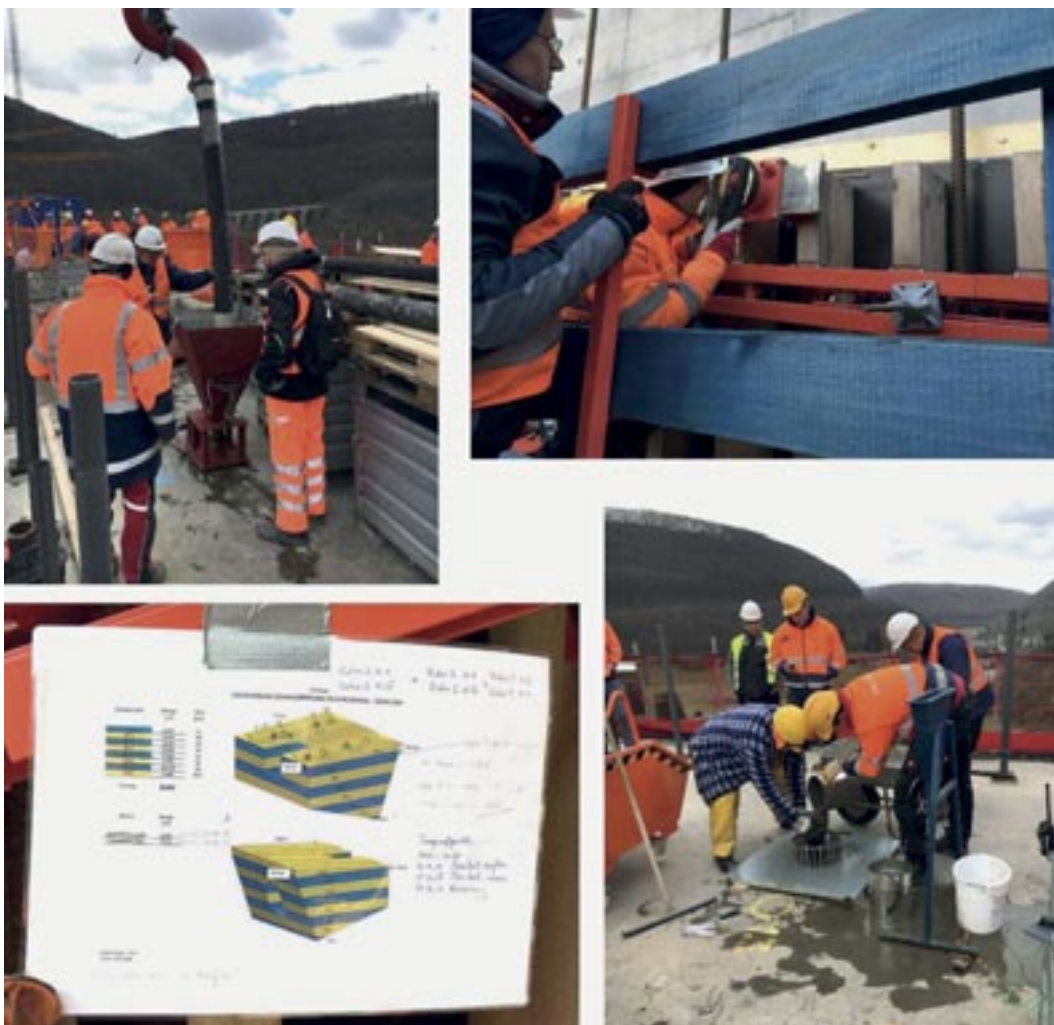
Abb. 17: Unterbetonage der Schrägstrebenanschlüsse mit selbstverdichtendem Beton
