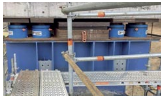
Abb. 20: Absenkvorrichtung an den Hilfsstützen mit Hydraulikpressen und Elastomerlagern
