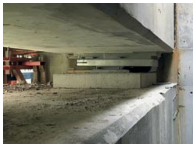
Abb. 7: Details der semi-integralen Bauweise: oben: Einbindung der Pfeiler in den Überbau, unten: Lagerung des Endquerträgers mit Kalottengleitlagern
