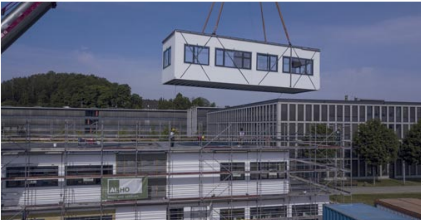
Abb. 5: Stahlmodul mit vielen Fensteröffnungen und temporären Verbänden
