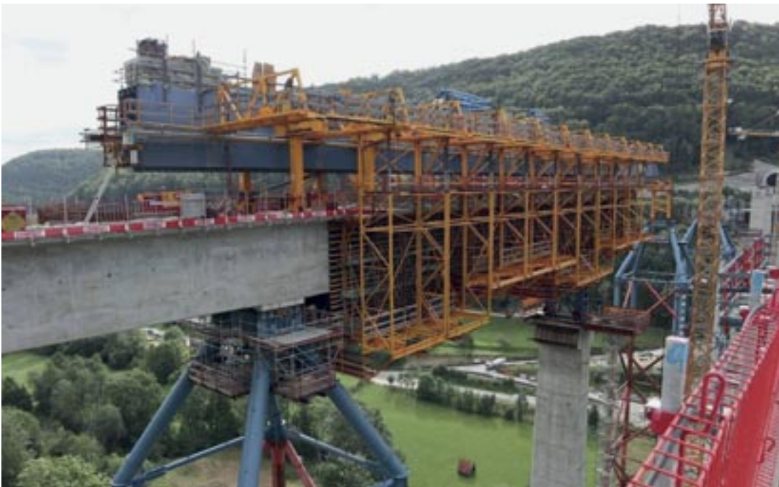
Abb. 15: Vorschubrüstung zur Herstellung der Überbauten
