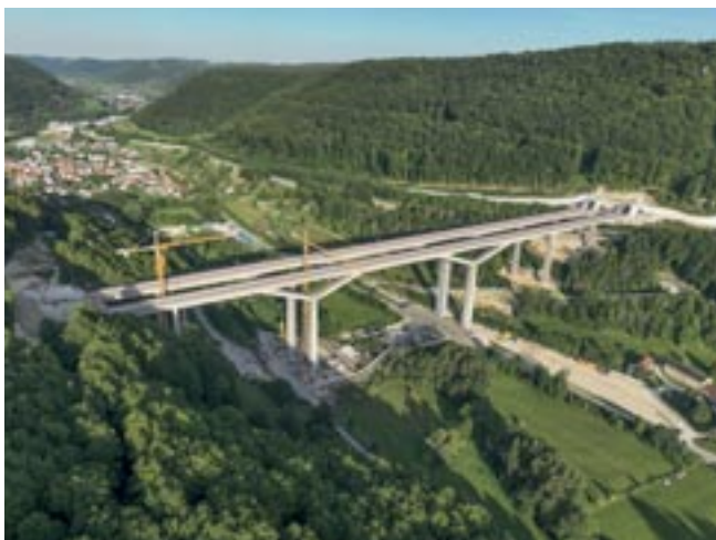
Abb. 2: Die Filstalbrücken: Die Randbedingungen ihres Baus erforderten eine Minimierung der Pfeilerstellungen.
