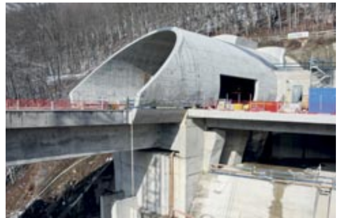
Abb. 6: Widerlager mit seitlich aufgelagerter Überfahrtsbrücke und Haubenbauwerk
