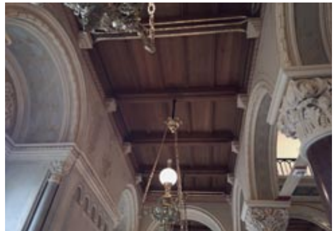
Abb. 15: Einvernehmlich nachgerüsteter Deckenbereich in einem Baudenkmal
