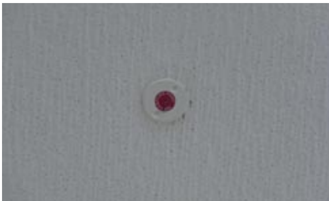
Abb. 16: Rauchansaugsystem
