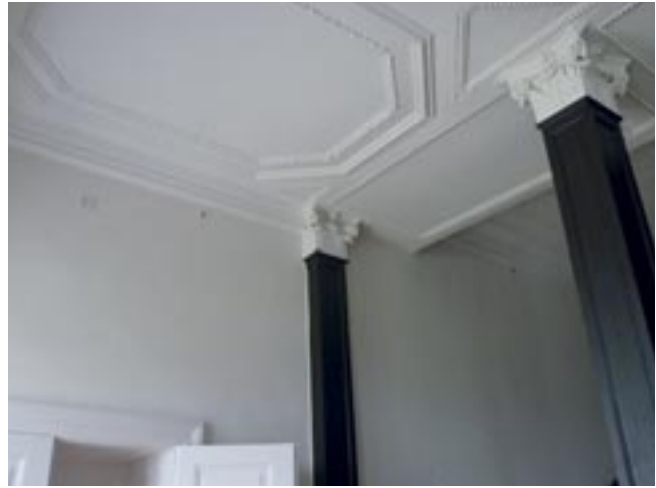
Abb. 23: Löschdüse (Wassernebel) in einem Treppenraum eines Schlossgebäudes
