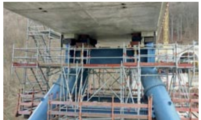
Abb. 19: Lückenschluss der Schrägstreben
