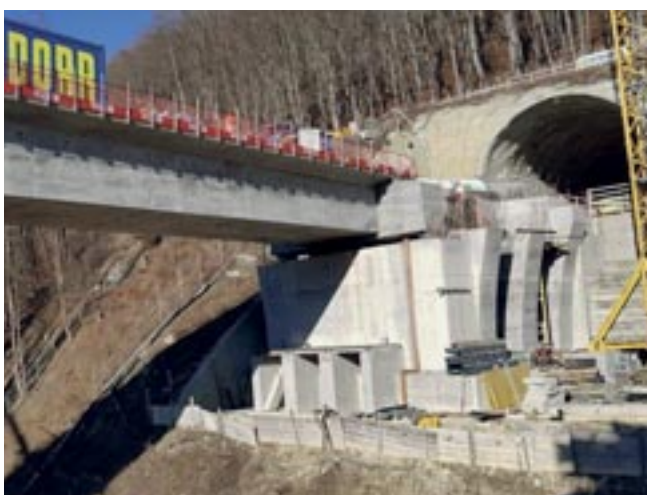
Abb. 7: Details der semi-integralen Bauweise: oben: Einbindung der Pfeiler in den Überbau, unten: Lagerung des Endquerträgers mit Kalottengleitlagern
