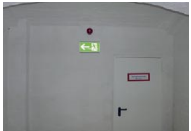
Abb. 7: Notwendige Brandschutzmaßnahmen wegen einer Nutzungsänderung: Löschanlage, Brandmelde- und Alarmanlage, Rettungswegkennzeichnung
