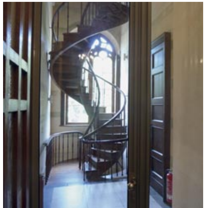
Abb. 20: Feuerschutzverglasung hinter einer historischen Tür
