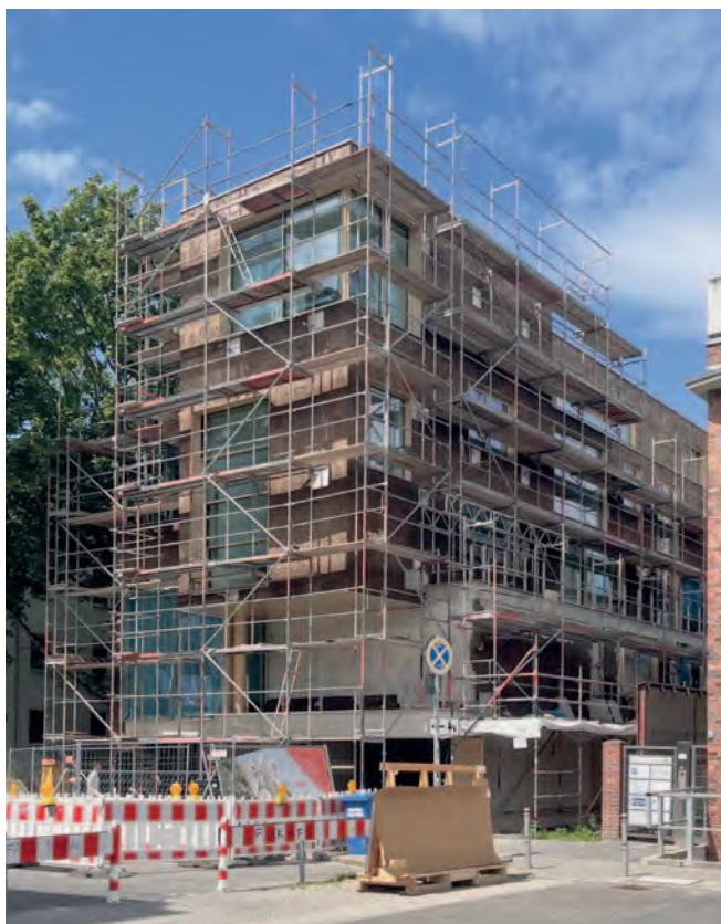
Abb. 9: Außenwandbekleidung aus regenerierbaren Rohstoffen: Wärmedämm-Verbundsystem mit Dämmkorkplatten und Sichtkork
