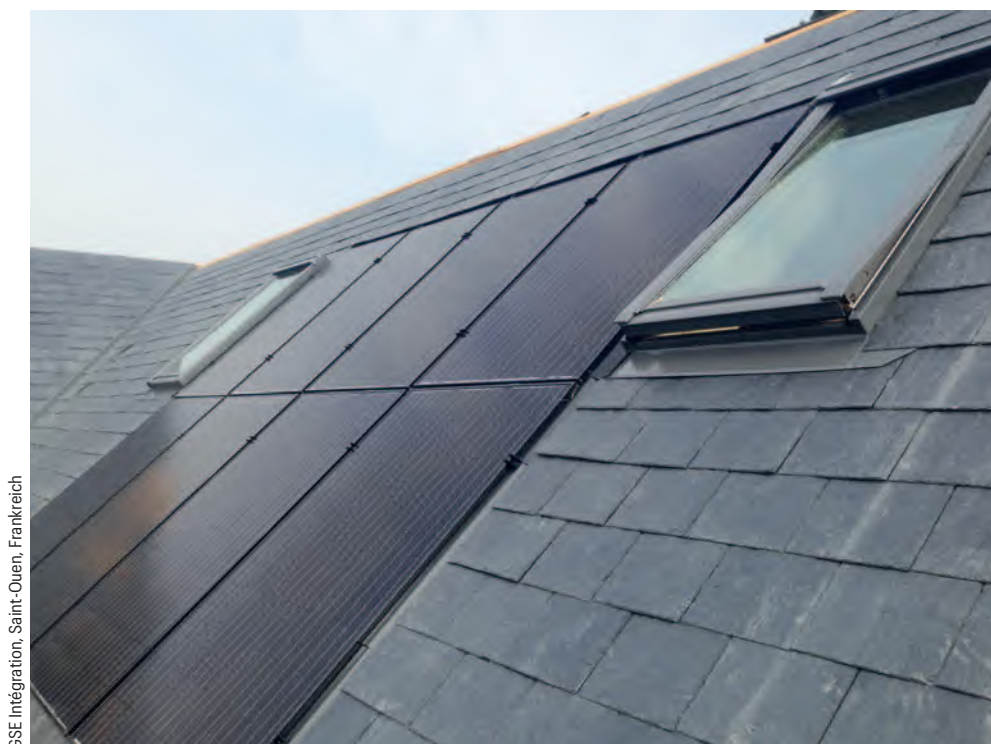
Abb. 1: Metallisches In-Roof-Montage-system zur Einbettung von PV-Modulen in die Ebene der Dachhaut. Gegenstand der abZ/aBG waren unter anderem die Widerstandsfähigkeit gegen Flugfeuer und strahlende Wärme der Bedachung.
