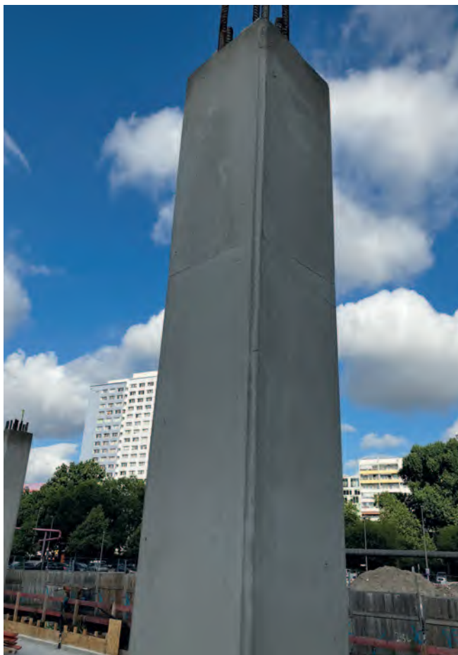
Abb. 2: Sieht aus wie normaler Beton: Betonbauteile aus klinker-armem Beton mit einem höheren Gehalt an Kalksandstein und Hütensand, dafür mit einem niedrigeren Gehalt an Portlandzement (Festigkeitsklassen 32,5 N/R und 42,5 N/R, Expositionsklassen XC1-XC4, XD1-XD3, XS1-XS3, XF1, XA1, XM1, Bemessung nach Eurocode 2 möglich)
