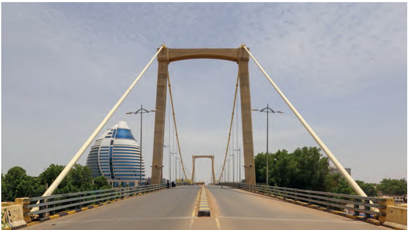
DIE TUTI-INSELBRÜCKE in Khartoum im Sudan quert mit einer Spannweite von 210 Metern den Blauen Nil. Sie wird von zwei Haupttragseilen aus jeweils neunzehn Spiralseilen mit einem Durchmesser von 70 Millimetern getragen.
