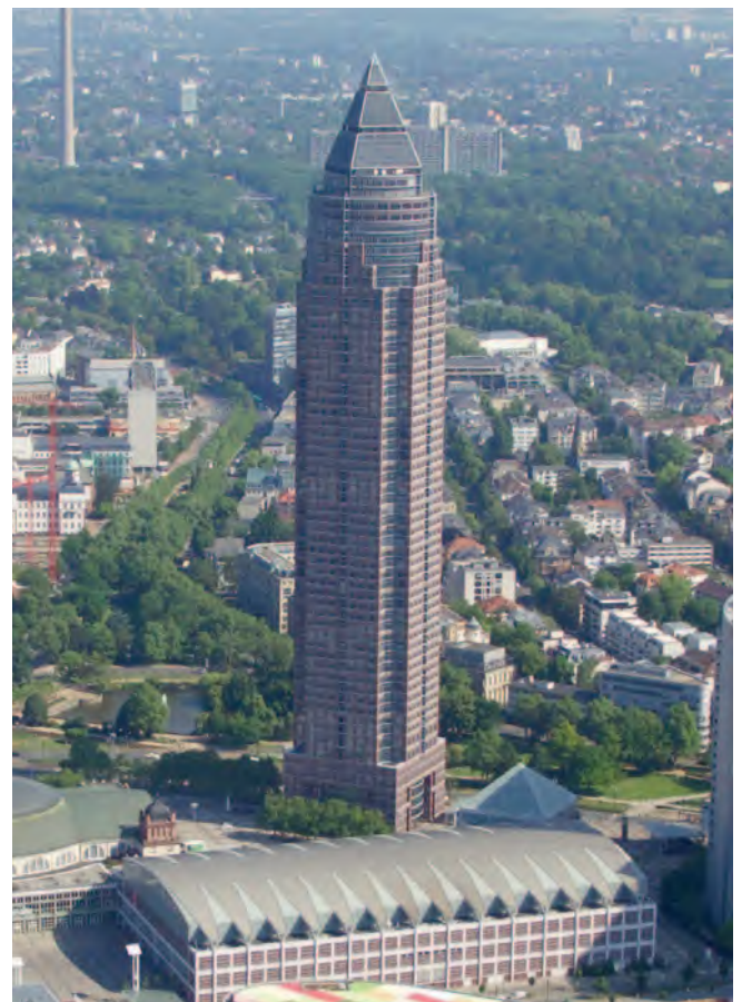
Abb. 1: Der Messturm in Frankfurt am Main: Prototyp für die Kombinierte Pfahl-Plattengründung
