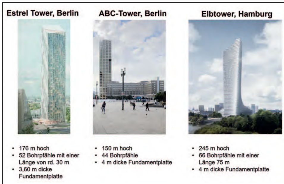
Abb. 17: Hochhäuser mit Kombierter Pfahl-Plattengründung
