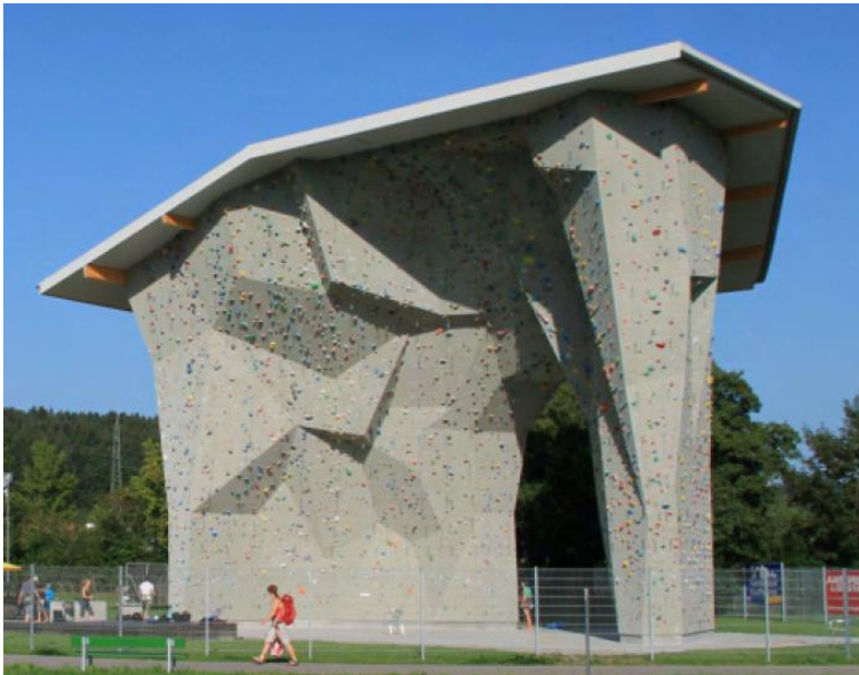
Abbildung 6-1 Kletterturm im fertigen Zustand
